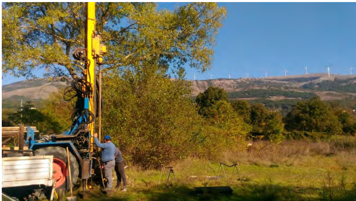
Esecuzione sondaggio in località Piè Delle Vigne
